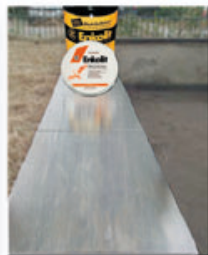
Hotové nalepené oplechování
