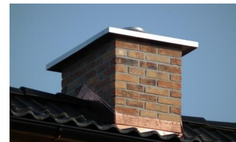
Keramo dvouprůduchový komín obezdění
