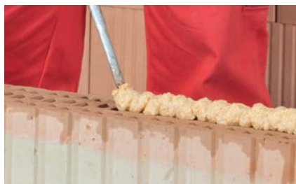
Technologie na zdicí pěnu Porotherm Dryfix
